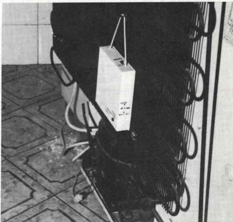
figura 1 - Come si presenta la realizzazione.
